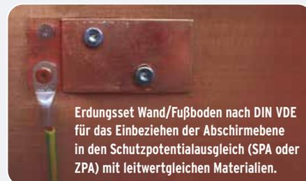
Erdungsset Wand/Fußboden nach DIN VDE für das Einbeziehen der Abschirmebene in den Schutzpotentialausgleich (SPA oder ZPA) mit leitwertgleichen Materialien.
