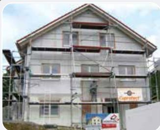
Fassadenabschirmung im WDV-System
