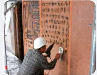
Fassadenabschirmung in Heißbitumen
