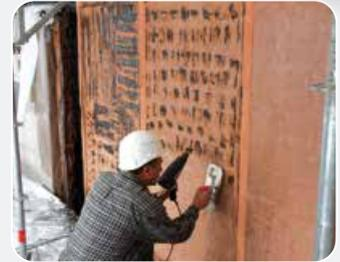
Fassadenabschirmung in Heißbitumen
