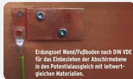
Erdungsset Wand/Fußboden nach DIN VDE für das Einziehen der Abschirmebene in den Potentialausgleich mit leitwertgleichen Materialien.
