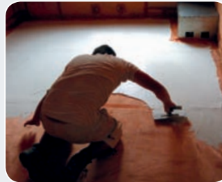
Fussbodenabschirmung in Spachtel
