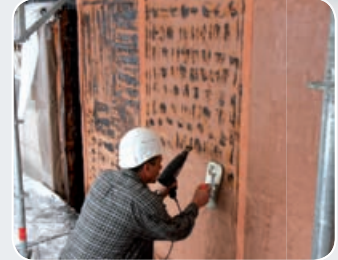
Fassadenabschirmung in Heißbitumen
