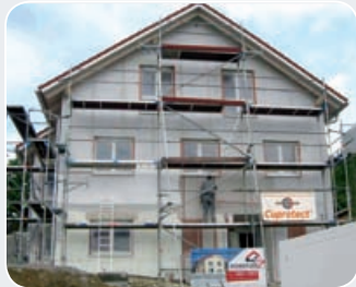
Fassadenabschirmung im WDV-System
