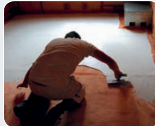
Fussbodenabschirmung in Spachtel
