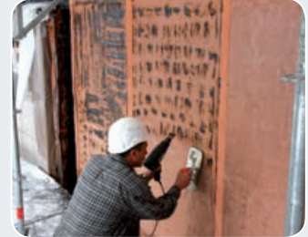
Fassadenabschirmung in Heißbitumen
