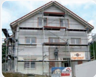
Fassadenabschirmung im WDV-System
