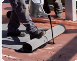
Flachdach mit Heißbitumen
