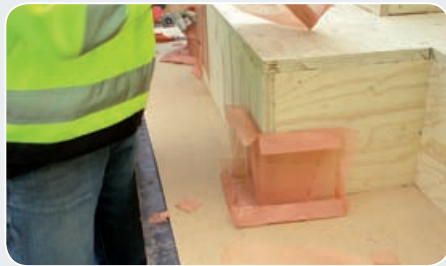
Setzen des ersten, 40 mm vorgefalteten Gewebestückes aus Cuprotect ® Spezial
