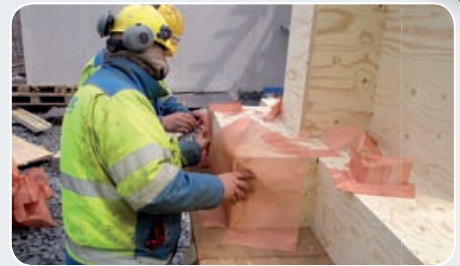
Abschirmung einer Außenecke
