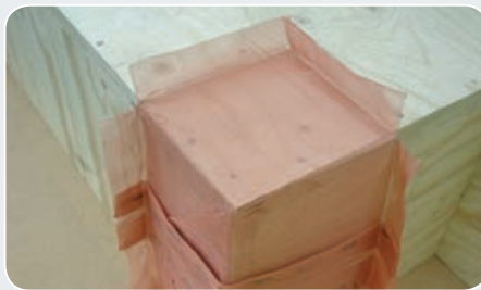
Anschluss oben mit aufgeklapptem Falz
